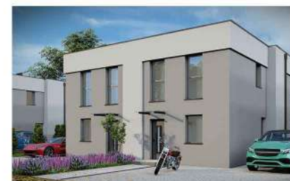
Widok od strony ulicy
