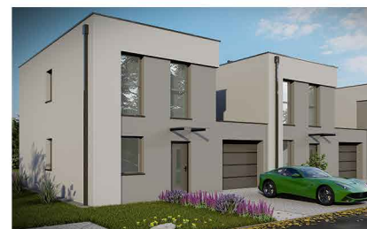
Widok od strony ulicy
